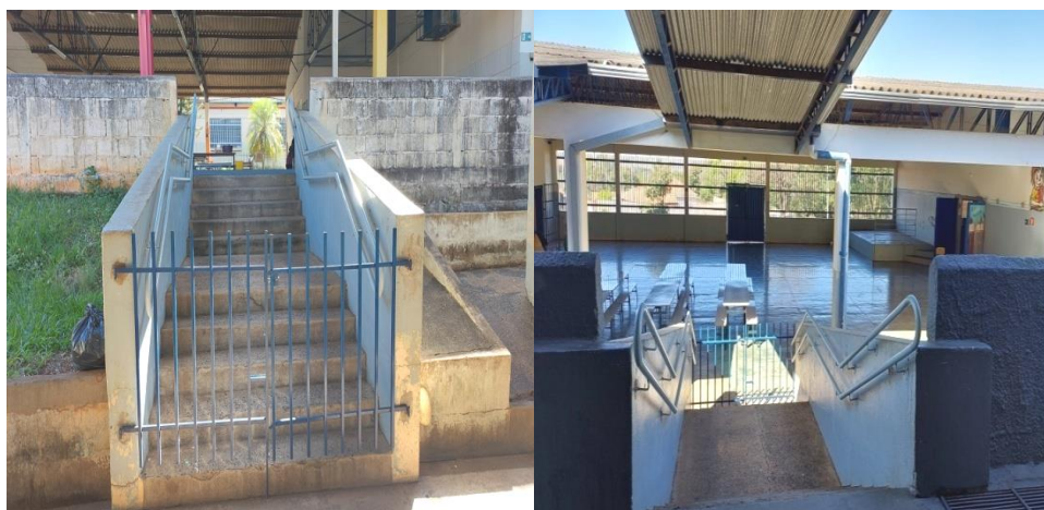
Figura 2. Fotos do Portão de acesso entre as escolas – vista de baixo para cima e de cima para baixo. Fonte: Acervo da pesquisadora.
