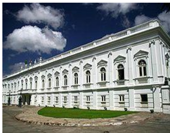
Foto 05 - O Forte de São Luís foi demolido em 1766 e no local foi construído o Palácio dos Leões - Sede do atual Governo do Maranhão. 73
