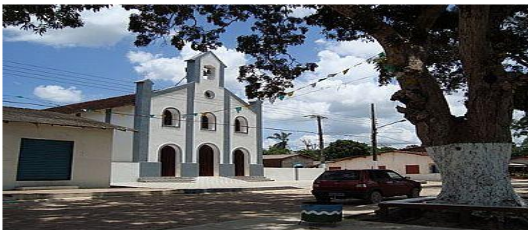
Foto 20: Igreja de São Tiago no centro de Mazagão
