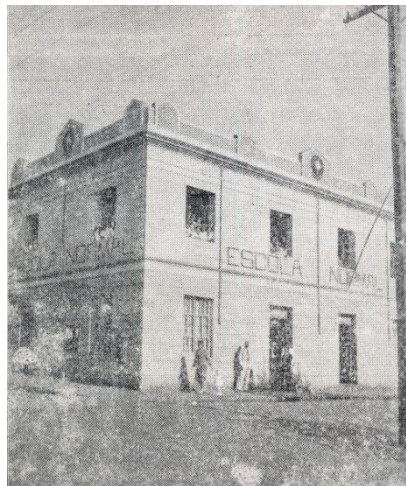
Figura 7- Vista do edifício da Escola Normal Livre
