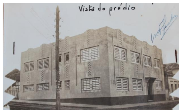
Figura 10 - Vista lateral do edifício do Ginásio do Estado
