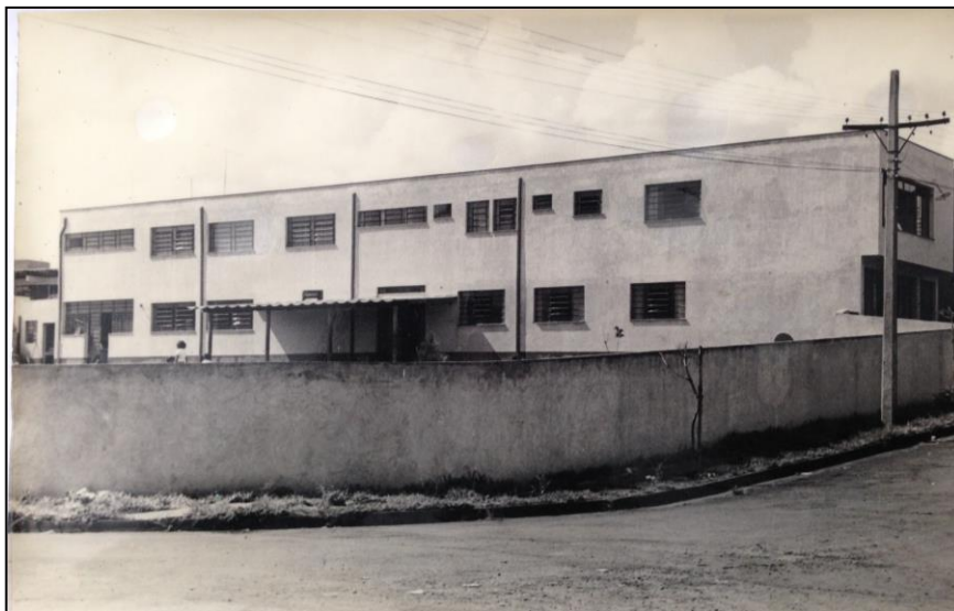
Foto 8 - Fachada do ILES em 1969.
