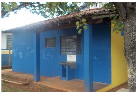
Figura 27: Vista exterior da S.R.M. 2 / fundos
