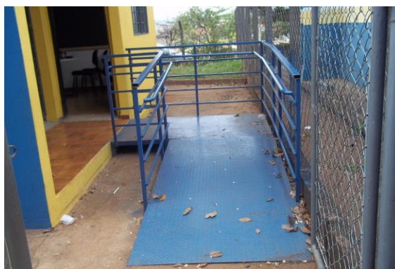
Figura 25: Rampa de acesso à S.R.M. 2
