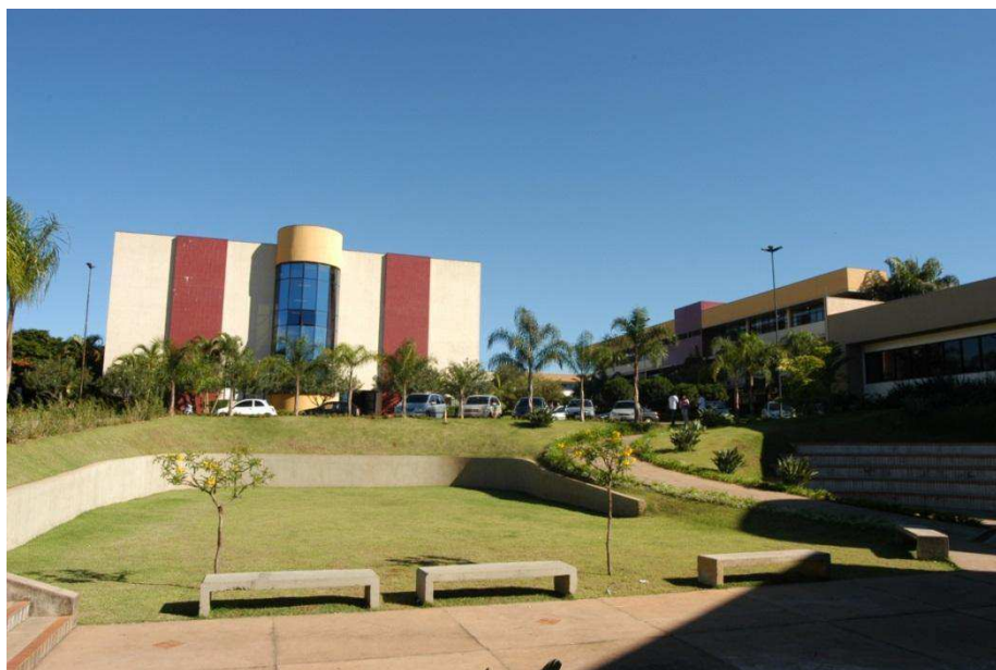
Figura 3 – Vista Parcial da Universidade de Franca (Bloco Bordô e Clínica de Odontologia)
