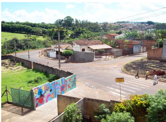
IMAGEM 7: O BAIRRO Portão de entrada da escola tendo ao fundo o bairro residencial Parque São Paulo e o córrego
