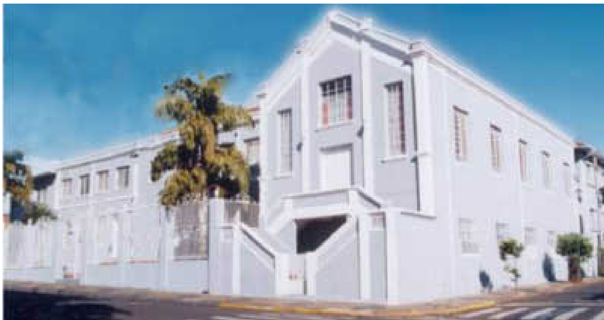
Figura 2- Fachada da FREA- Fundação Regional Educacional de Avaré – em dezembro de 2007
