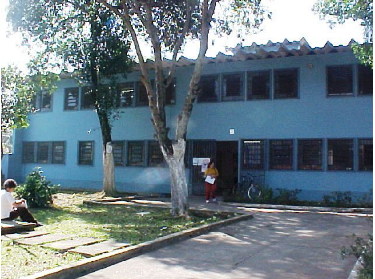
Foto nº 7: Entrada do Centro de Saúde Umuarama
