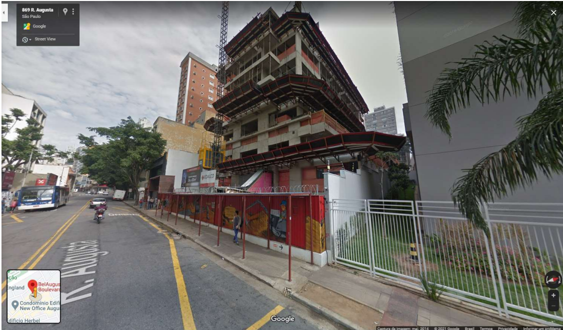
Figura 7 - Imagem de maio de 2014, capturada do Google Street View, em 14/04/2021. Mostra o BelAugusta em construção.
