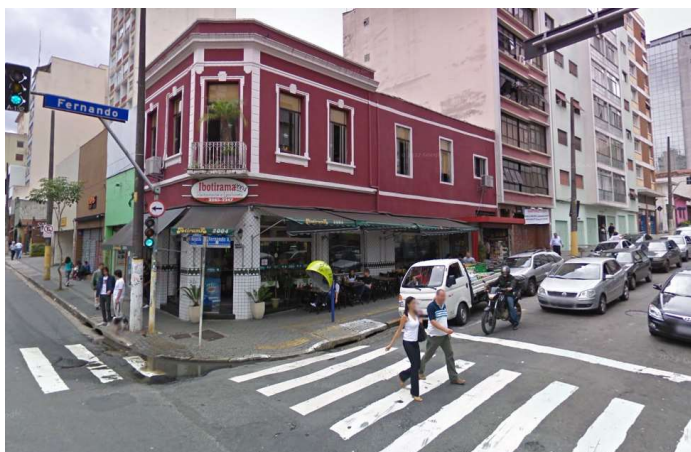
Figura 32 - Imagem da fachada do bar Ibotirama em 2010. Capturada do Google Street View em 07/02/2023.
