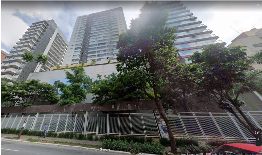
Figura 9 - Fundos do Edifício Bela Cintra, na Rua Augusta, protegido por gradis e alto muro. Imagem de março de 2022 capturada do Google Street View em 26/01/2023.
