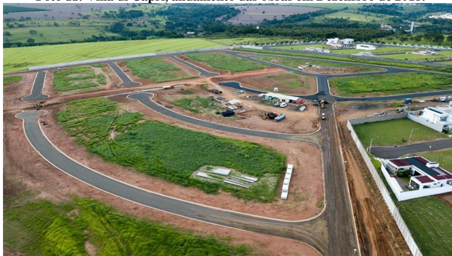
Foto 11: Villa di Capri, andamento das obras em Dezembro de 2018.
