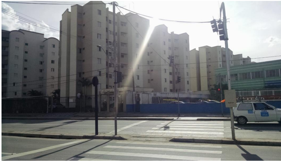
Figura 7: Entorno do Condomínio.
