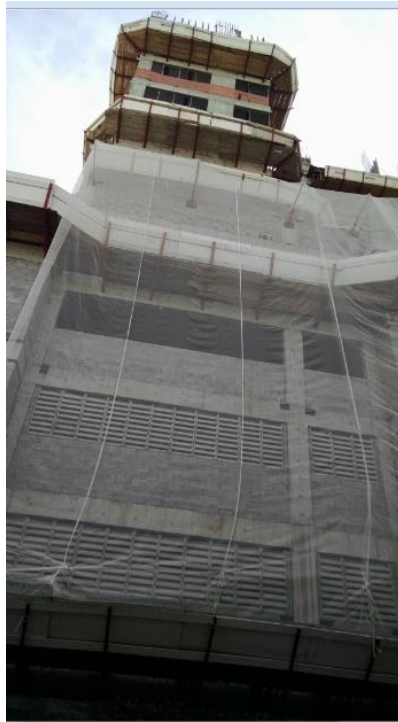
Figura 9: Construção de prédio próximo ao condomínio.
