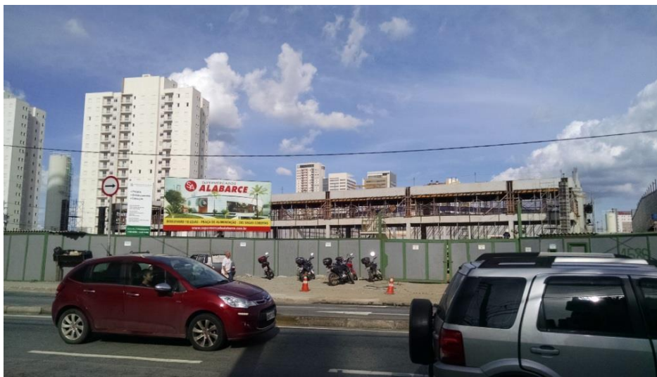
Figura 8: Construção de um Supermercado próximo ao Condomínio.
