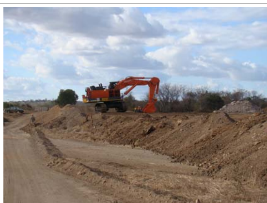
Foto 10 – Obras de abertura de estradas do PCM.
