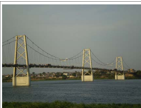
Foto 1 – Ponte Samora Machel, que liga a cidade de Tete ao distrito de Moatize.
