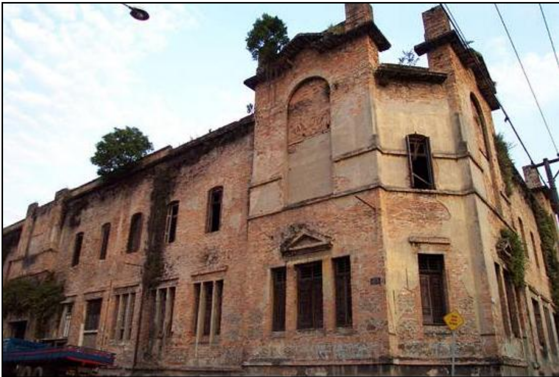
Figura 35 - Hospedaria dos Imigrantes no bairro Vila Nova que irá abrigar a Faculdade de Tecnologia - Fatec (PMS, 2012).
