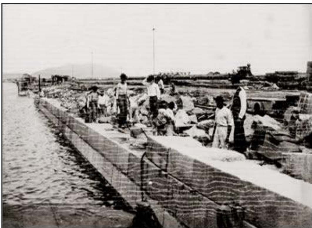
Figura 04 - Construção do primeiro trecho de cais (NOVO MILÊNIO, 2010).
