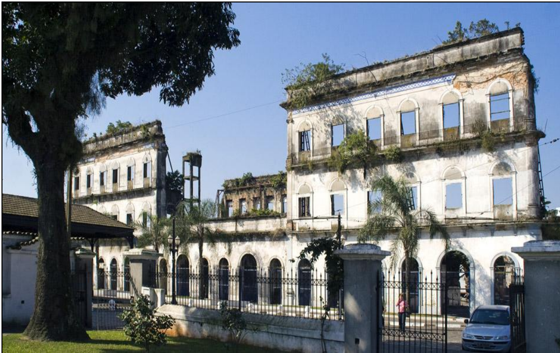
Figura 30 - Ruínas dos Casarões do Valongo cedidos pelo governo do estado (PMS, 2012).
