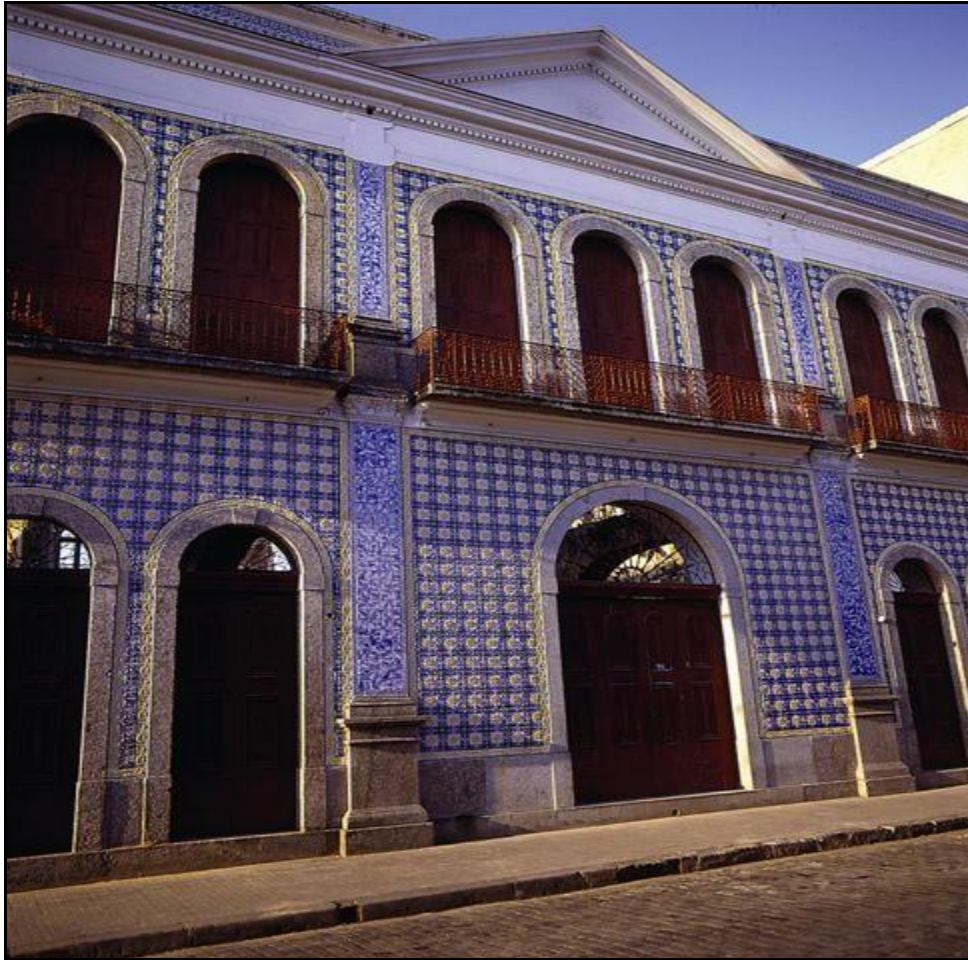
Figura 21 - Casa da Frontaria Azulejada restaurada (NOVO MILÊNIO, 2012).
