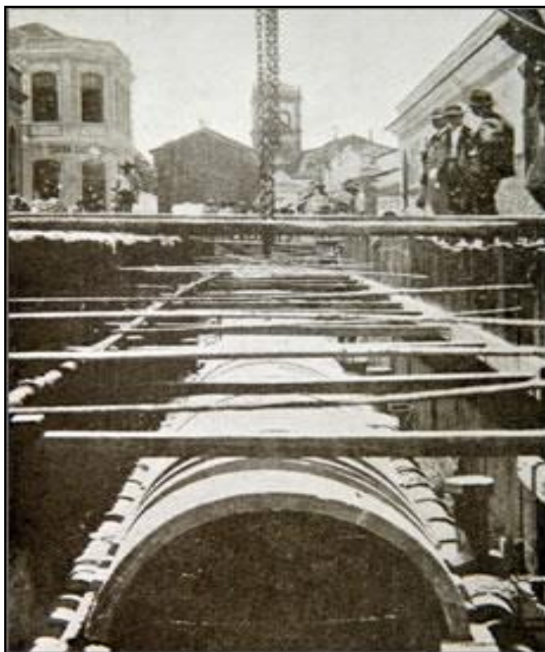
Figura 09 - Obras da canalização do Ribeirão do Itororó (VIVA SANTOS, 2010).
